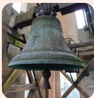
La cloche d'origine, Jésus Marie et Joseph (1670) mesure 0.620 m de diamètre et pèse environ 125 kg
